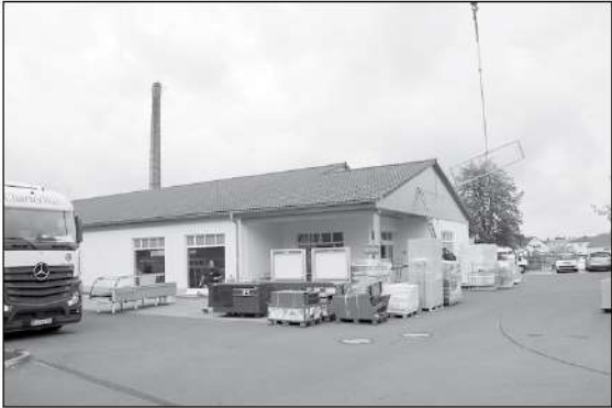
Seit 18. September erwartet der Netto-Markt an der Hempelstraße wieder seine Kunden. Nach dem umfangreichen Umbau gibt es frische Backwaren auch aus dem eigenen Backshop, frisches Fleisch und Wurst bekommt man an der Bedientecke.
